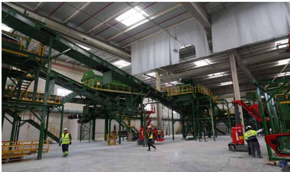
Una de las dependencias de la planta de tratamiento de residuos que se construye en la Ciudad del Transporte, en el Valle de Elorz.
